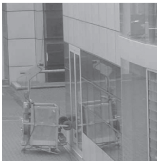
Fig. 38 Nacelle pour le nettoyage d'une façade.
